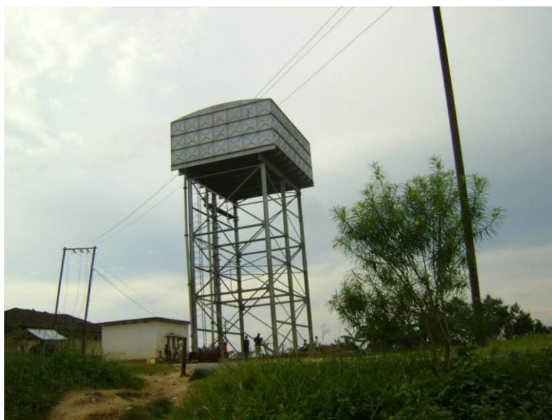
Photo n° 6 : Le principal château d'eau construit depuis l'époque coloniale qui dessert la ville à ce jour
